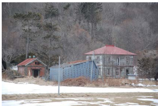
老朽化が進み、今後の去就が心配されている旧斉藤牧場事務所 1903（明治36）年ころの建築と考えられている
